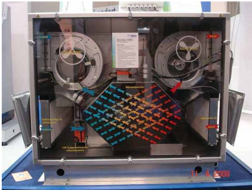
Abbildung 4: Wärmerückgewinnungseinheit des Lüftungsgerätes (Quelle: klimatherm)
