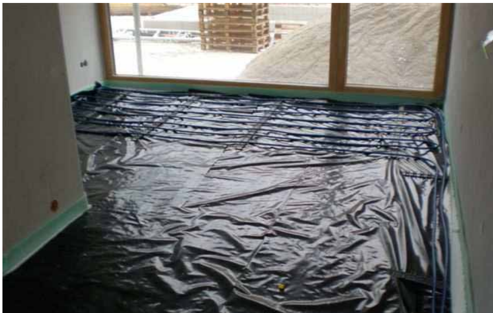
Abbildung 3: Fußbodenheizung in den Außenbereichen (Quelle: klimatherm)
